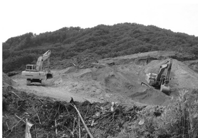
住宅の高台移転のための土地造成工事の様子(大船渡市)
